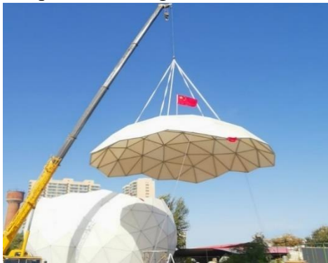
Fig 1.a 17m span Radome
