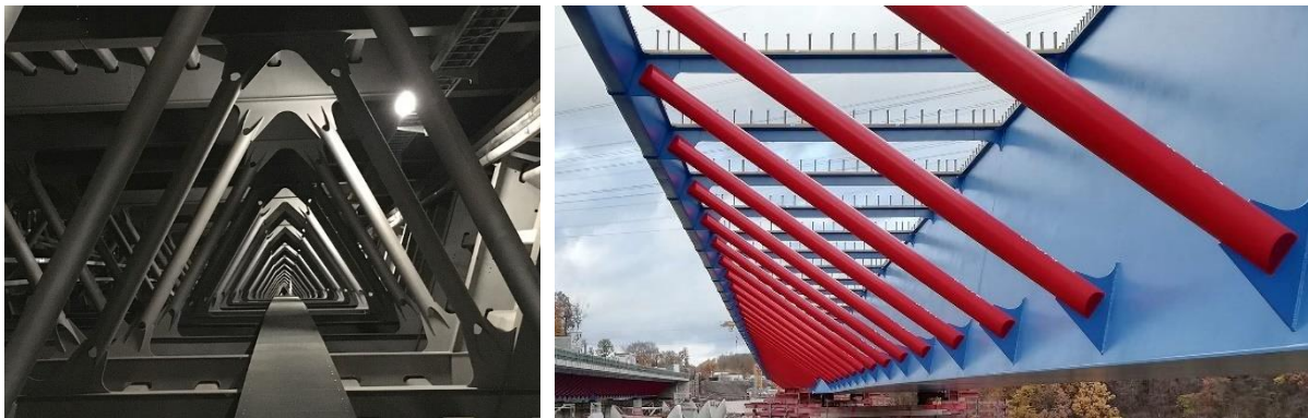
Abb. 1-1 Rohranschlüsse an Brücken, Schiersteinerbrücke (links) [27] und Lenttalbrücke (rechts) [26]
