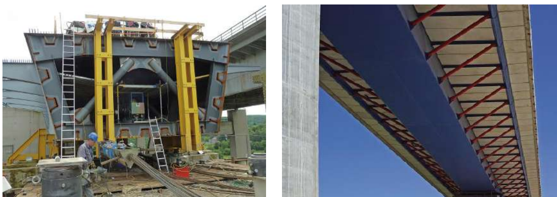
Abb. 1-1: Diagonalrohr-Anschlüsse innenliegend (Talbrücke Heidingsfeld li.) und außenliegend (Talbrücke Lennetalbrücke re.) [24, 32]
