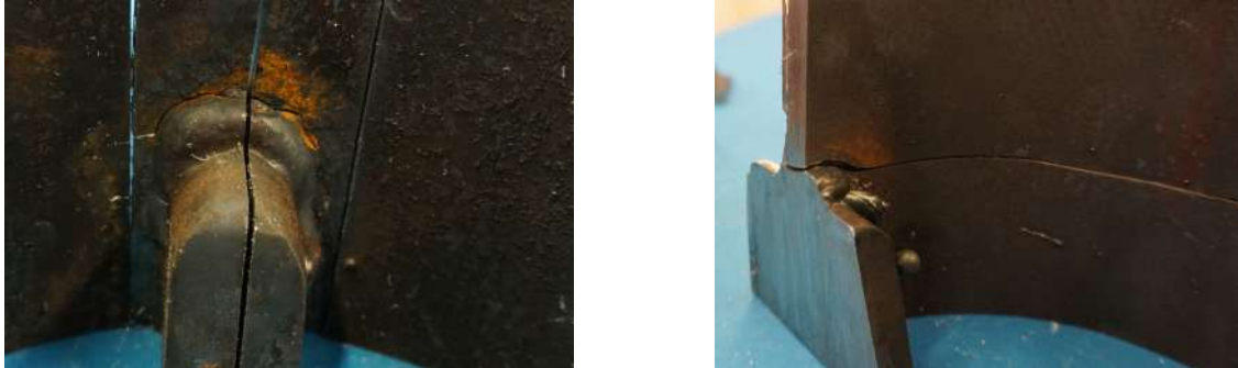
Abb. 5-26: Rissenstehung E 3-7 (li.) und E 3-6 (re.) [21]
