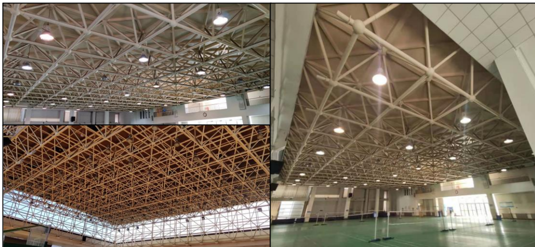
图 1-1 天津一中预应力空间网架结构 [3]
