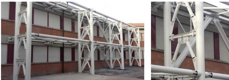
Figura 25: Retrofit sismico della Scuola secondaria di primo grado "A.Fiori" di Formigine (Mo)
