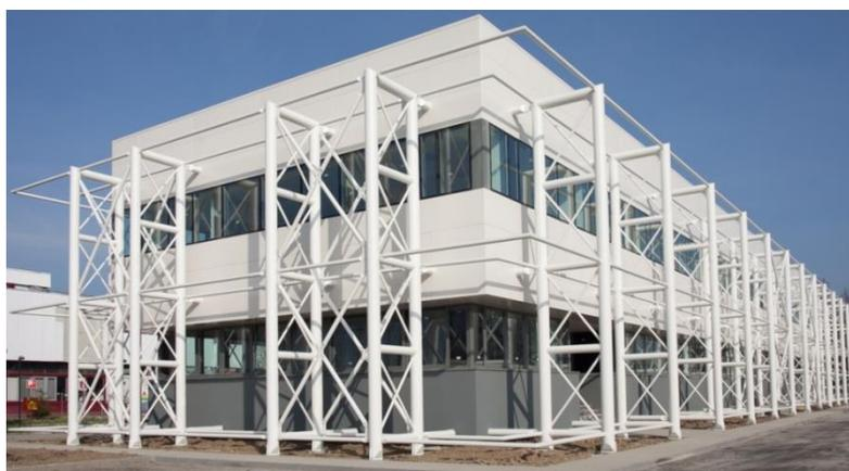
Figura 12: Organismo strutturale del sistema post-operam: vista d'insieme dell'intervento [Franceschini et al, 2014]
