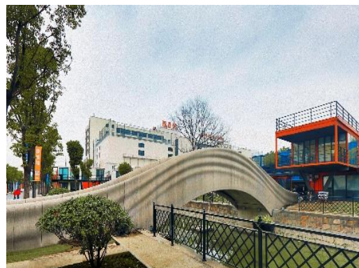
b) 3D 打印混凝土桥
