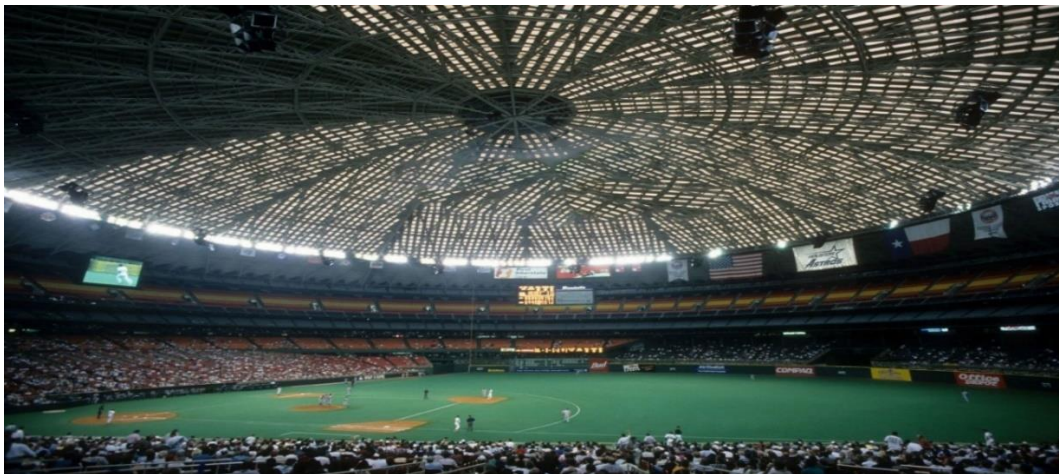
Rys. 1.21. Hala Astrodome w Houston (USA)-konstrukcja dachu [W10]
