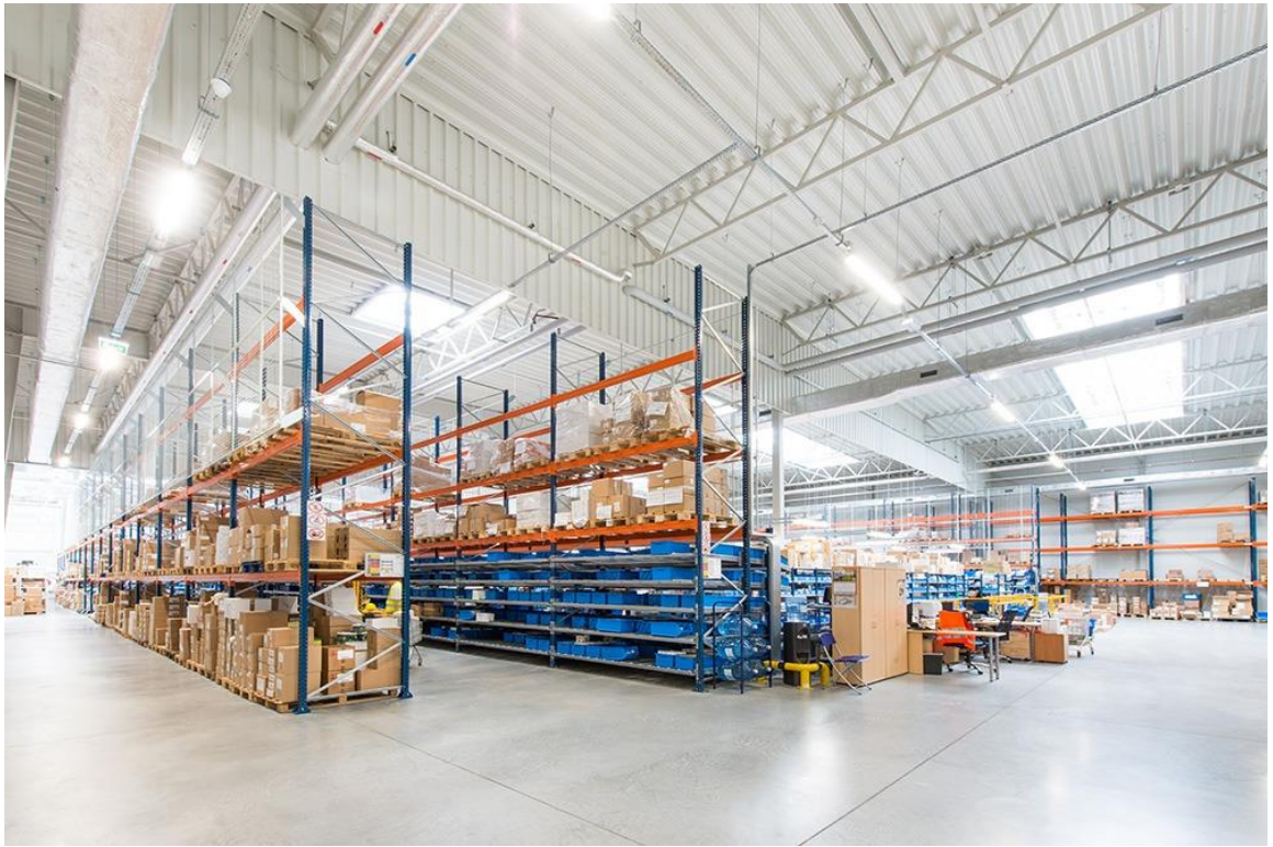
Rys. 1.2. Hala magazynowa wysokiego składowania [W1]
