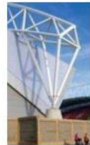
Rys. 1.19. Stadion Thomond Park w Limerick (Irlandia): a) przekrój poprzeczny przekrycia i trybun, b) szczegół podparcia łuku, c) widok łuku kratowego o przekroju trójkątnym o rozpiętości 150 m, d) widok podparcia łuku [5]
