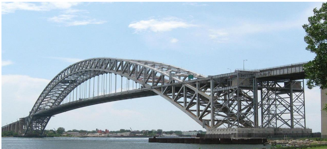
Rys. 1.30. Most Bayonne Bridge w Stanach Zjednoczonych [W15]
