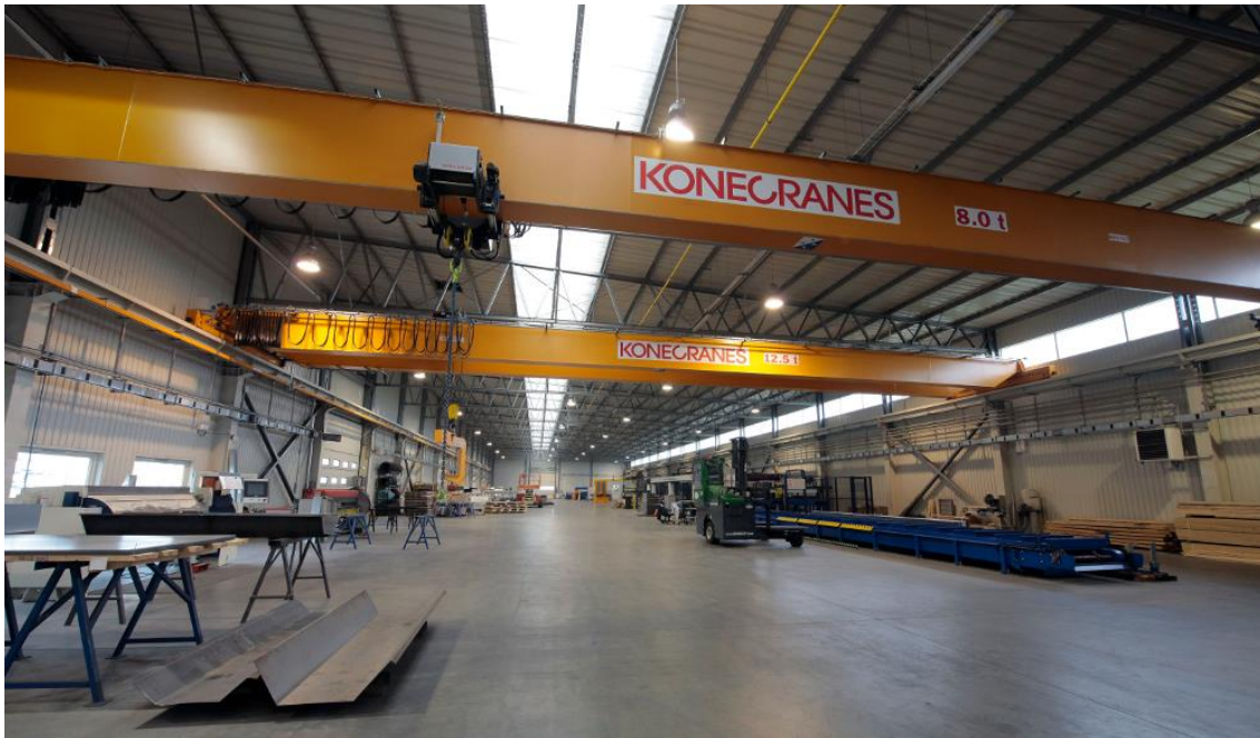
Rys. 1.3. Hala przemysłowa stalowa z dwiema suwnicami o udźwigu 8 i 12,5 tony [W2]
