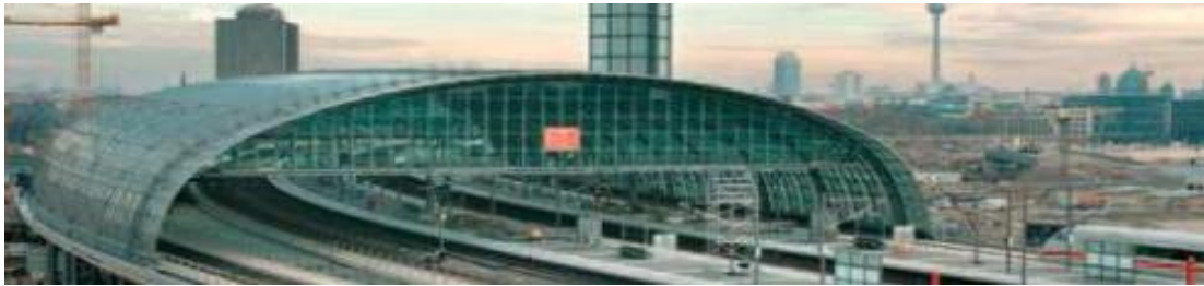
Rys. 1.31. Szklany dach na konstrukcji łukowej nad peronem: widok ogólny przekrycia peronów [5]
