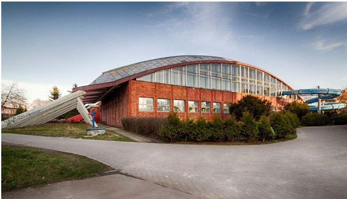
Rys. 2.8. Widok obiektu [W23]
