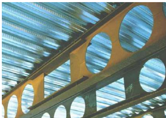
(б) укрупњено ребро око отвора
